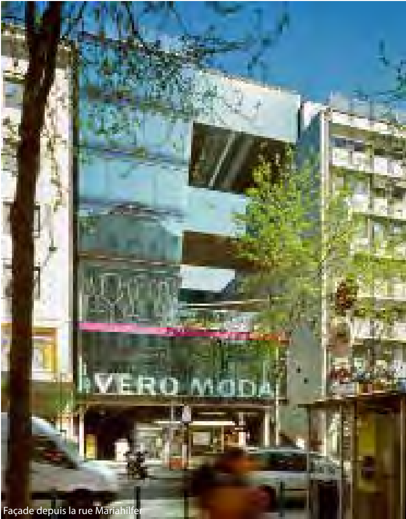
Façade depuis la rue Mariahilfer
