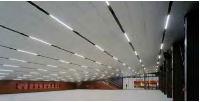
Dilatation du hall vers l'extérieur
